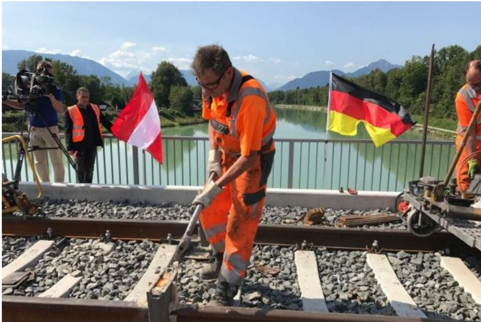
Schlusschweißung auf der Saalachbrücke für das dritte Gleis Salzburg-Freilassing. - © ÖBB
